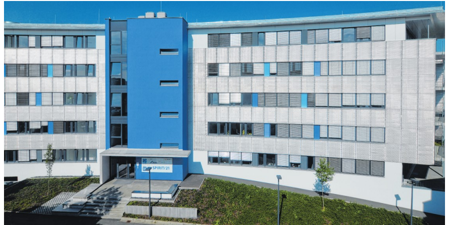
Das jüngste Bürogebäude auf dem Gelände des Softwarezentrums.
